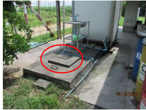
รูปที่ 2-6 ห้องสุขาและบ่อเกรอะในพื้นที่ฐานหลุมผลิต
