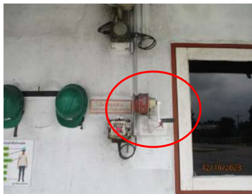
รูปที่ 2-23 การติดตั้งสัญญาณเตือนภัยภายในพื้นที่โครงการ
