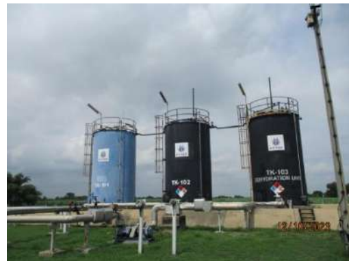
รูปที่ 2-8 คันคอนกรีตล้อมรอบถังกักเก็บ
