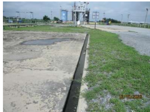
รูปที่ 2-7 บ่อคอนกรีตเก็บน้ำ (Concrete Pit) และรางระบายน้ำล้อมรอบพื้นที่ผลิต
